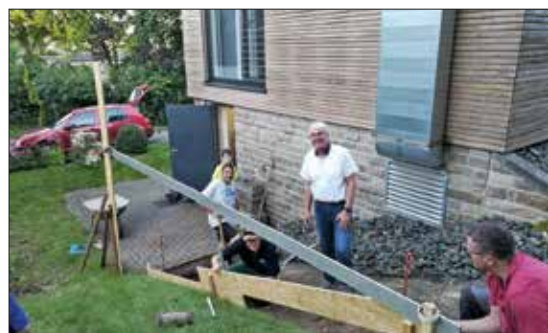
Gemeinsamer Arbeitseinsatz am Dorfhaus
